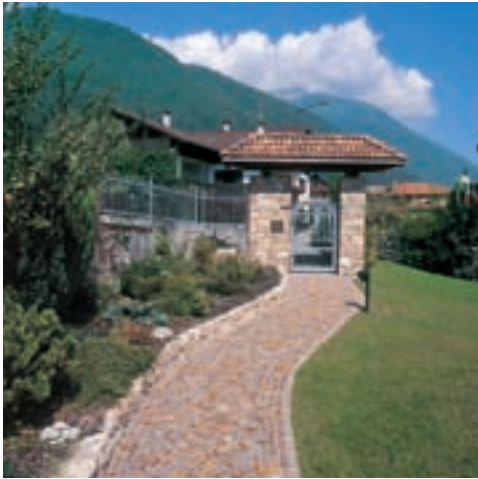
Pavimentazione pedonale in Porfido Trentino Lastrificato (Roverè della Luna)
