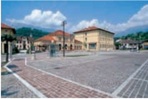
Pavimentazione in Porfido Trentino Lastrificato, Piazza Municipio di Puos D'Alpago (Belluno)
