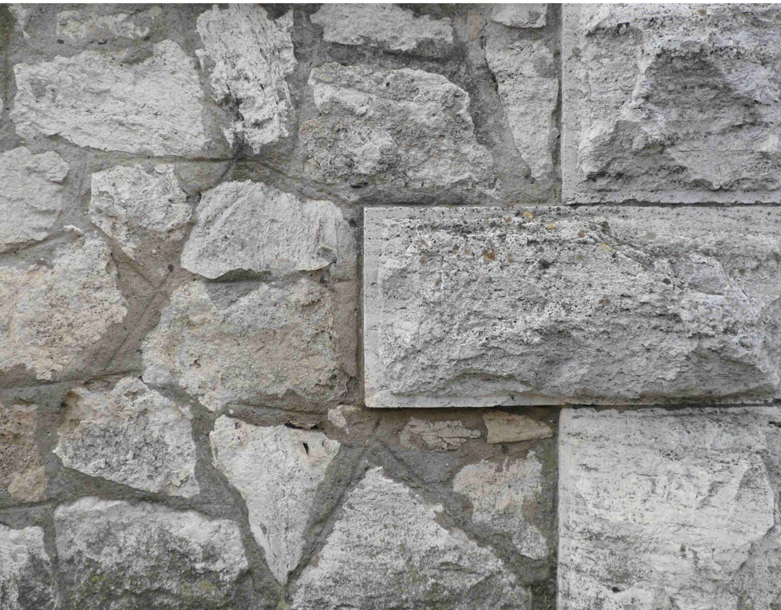
Muro rustico in travertino di Rapolano con rinforzo angolare in elementi bugnati. Rustic wall in Rapolano travertine with corners reinforced by rusticated ashlar blocks.
